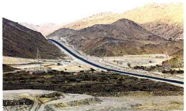
→ Le pays possède des infrastructures flamant neuves. Ici, une gigantesque autoroute.
