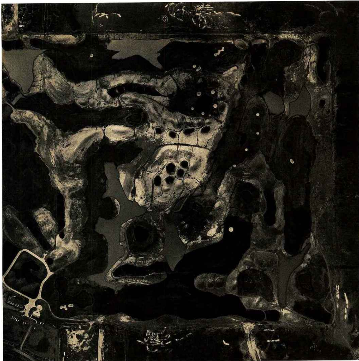
Terrain de golf en construction (Arizona), 1993
